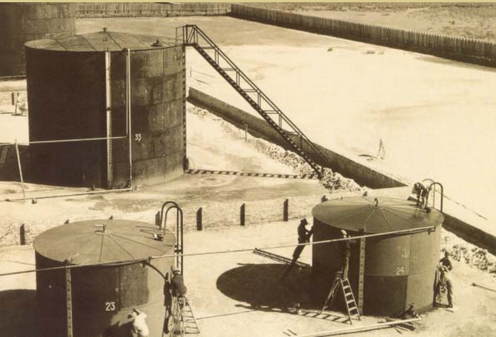
Tanques da refinaria da Ipiranga em Rio Grande - 1937
