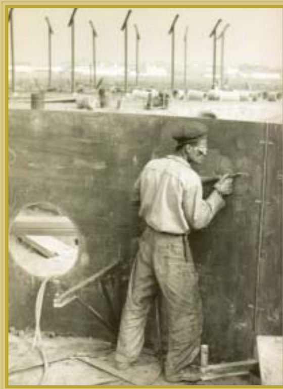
Construção da Refinaria de Manguinhos
