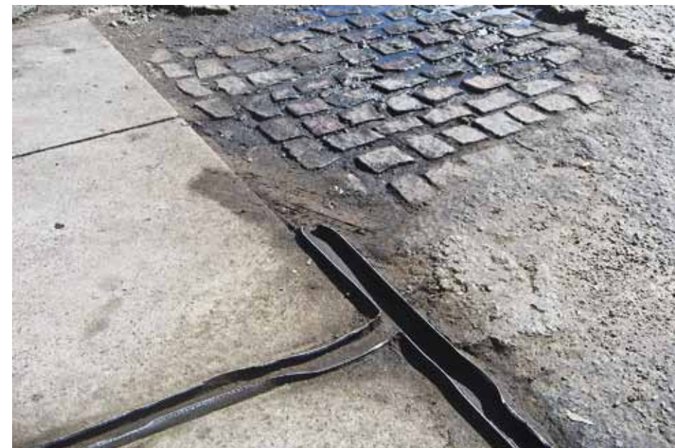
Figura 6.18: Desconformidade nas canaletas amassadas e danificadas Fonte: Ministério Público/RN
