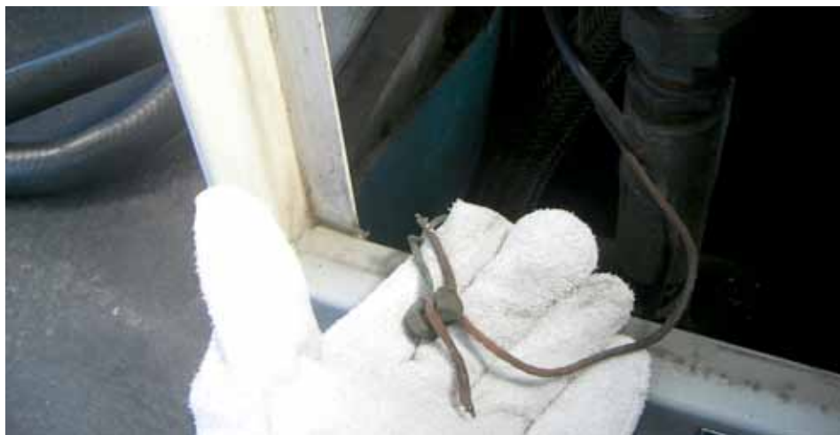
Figura 6.33: Aterramento de uma bomba completamente solto. Fonte: Ministério Público/RN
