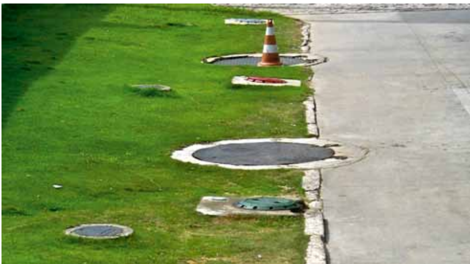
Figura 6.6: Piso da área de tancagem não conforme com tanques diretamente no solo. Fonte: Ministério Público/RN
