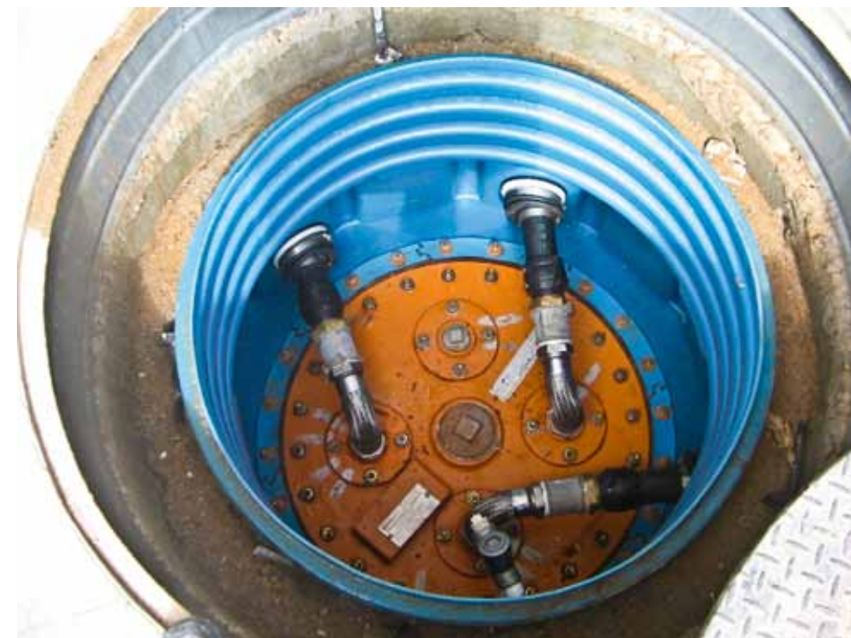
Figura 7.15: Sump instalado na boca-de-visita dos tanques. Fonte: Ministério Público/RN
