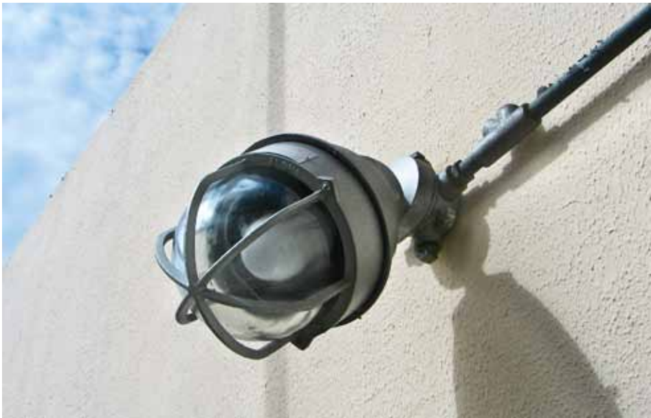
Figura 7.24: Luminária antiexplosiva instalada na área de compressão do GNV. Fonte: Ministério Público/RN
