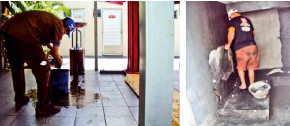
Figura 9.5: Vazamento na troca de óleo (na limpeza, observa-se que o funcionário está exposto à contaminação através da absorção pela pele).
