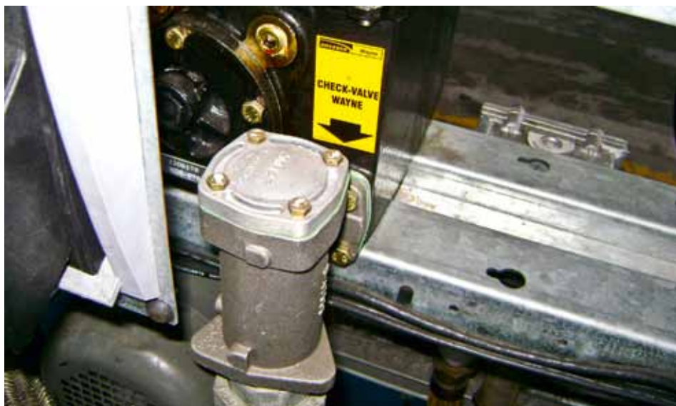
Figura 7.2: O componente Check-Valve , que evita vazamentos para o solo. Fonte: Ministério Público/RN
