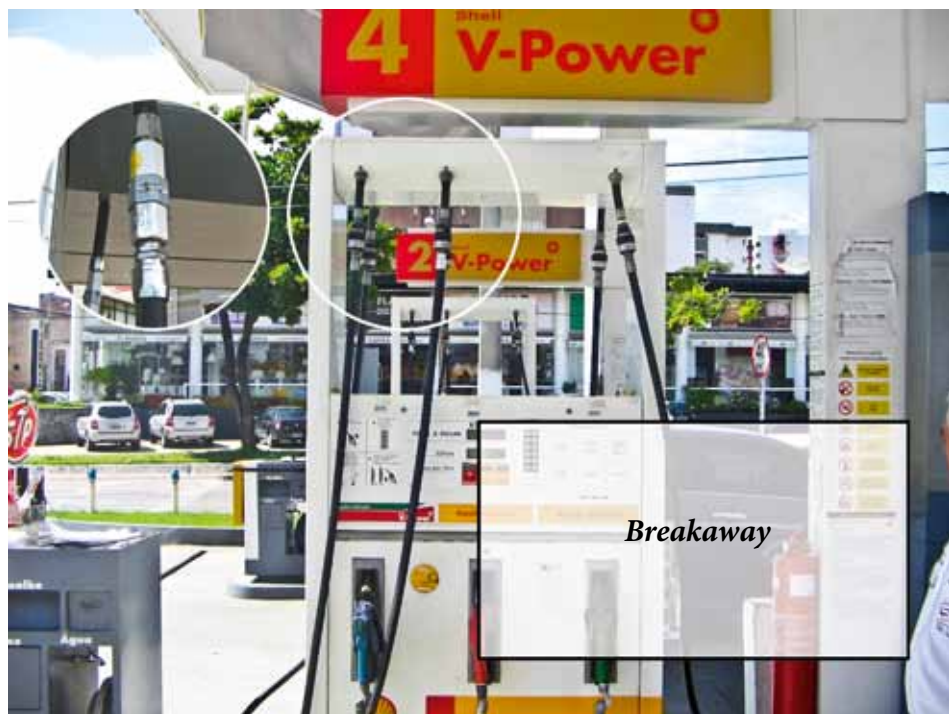
Figura 7.16: Válvulas Breakaways instaladas nas mangueiras das bombas de combustível. Fonte: Ministério Público/RN
