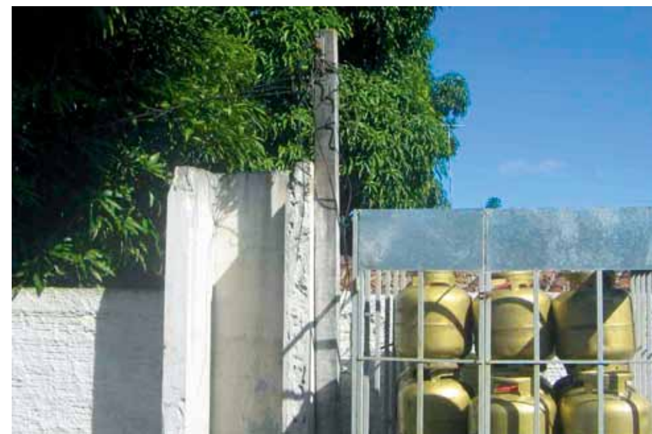
Figura 6.35: “Gaiola” dos botijões de GLP muito próxima ao poste da rede elétrica. Fonte: Ministério Público/RN
