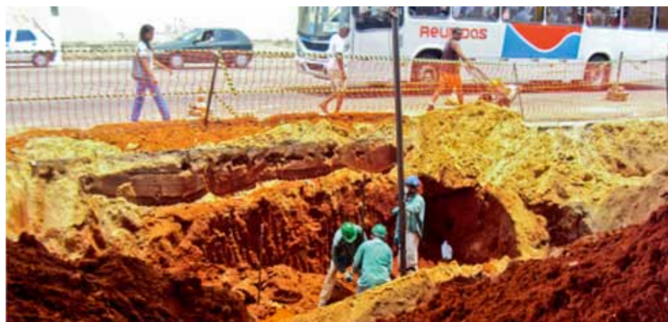
Figura 9.26: Coleta de solo na cava de tanques.
