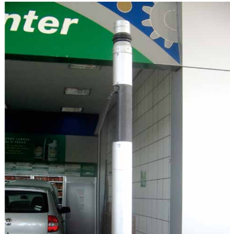
Figura 7.21: Válvula antitransbordamento montada no tubo de enchimento. Fonte: Ministério Público/RN
