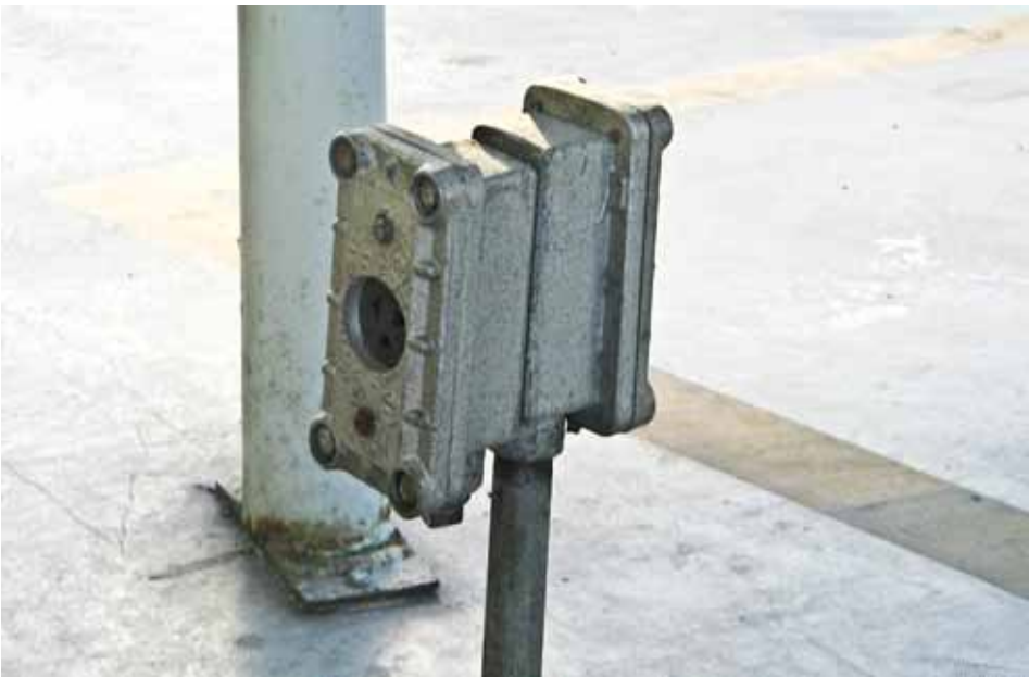
Figura 7.26: Tomada elétrica instalada a uma altura superior a 0,5 m. Fonte: Ministério Público/RN
