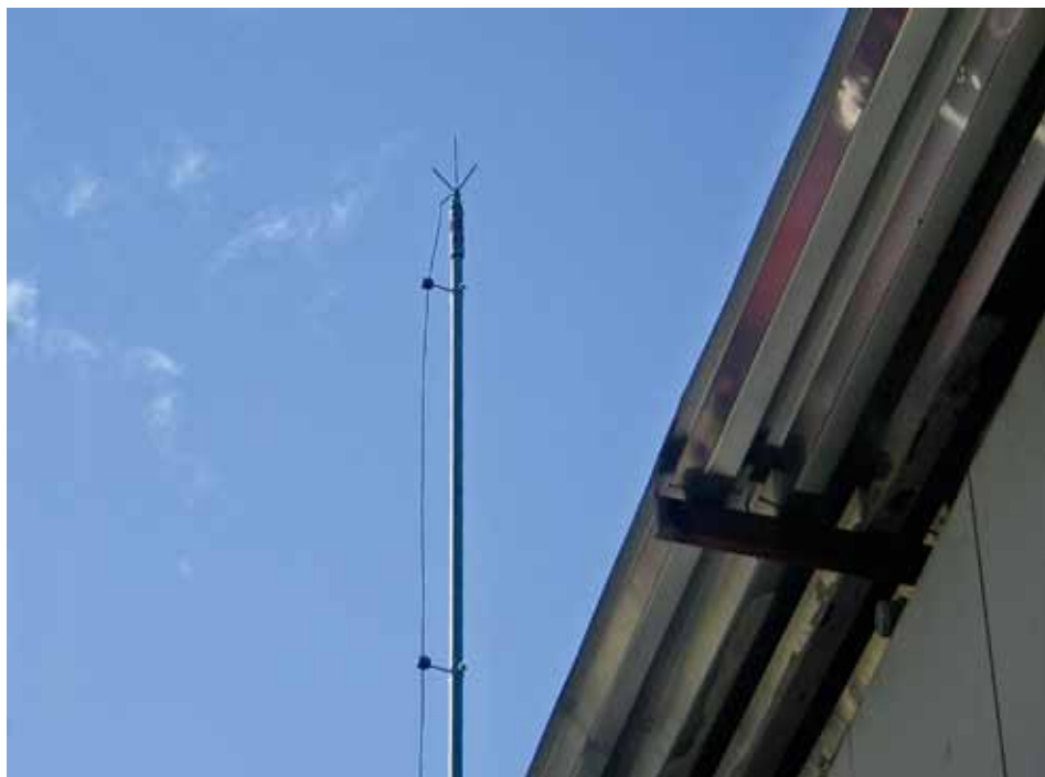
Figura 7.32: Para-raios instalado em um posto de combustível. Fonte: Ministério Público/RN
