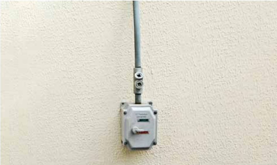
Figura 7.25: Chave liga-desliga à prova de explosão e unidade correspondente. Fonte: Ministério Público/RN
