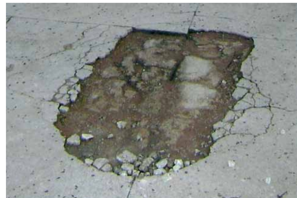
Figura 6.21: Piso desconforme devido a danos/ material e espessura inadequada. Fonte: Ministério Público/RN
