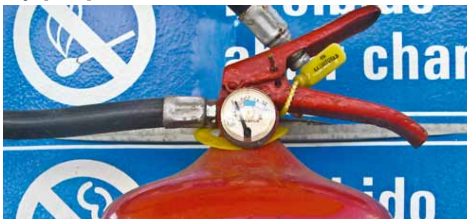
Figura 6.34: Exemplo de extintor descarregado encontrado durante as perícias. Fonte: Ministério Público/RN
