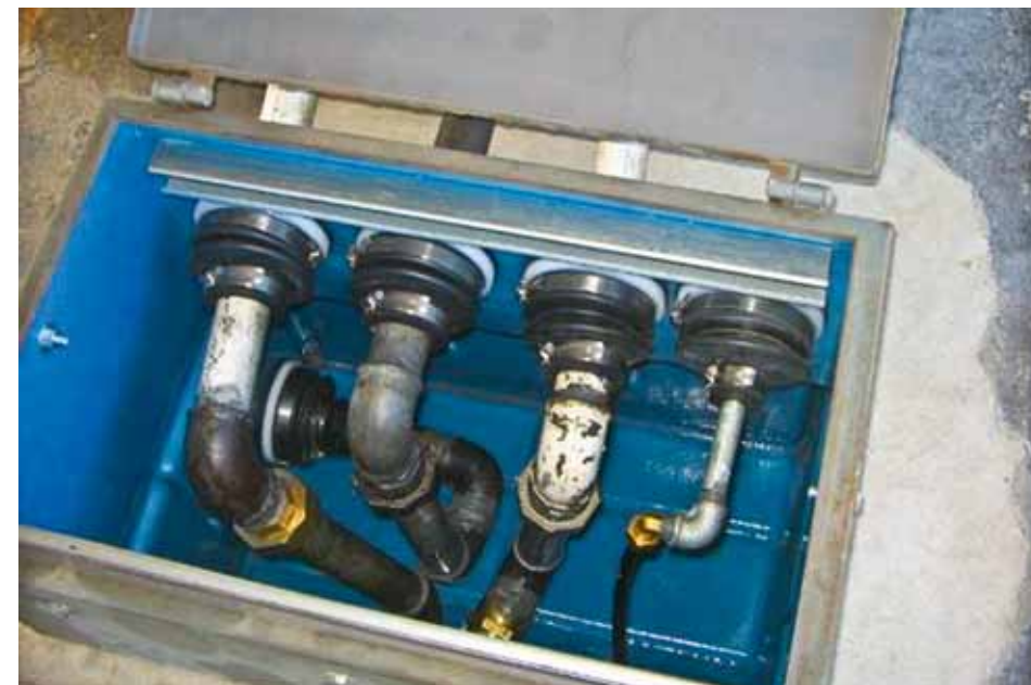
Figura 7.5: Sump (recipiente azul) instalado no filtro de Diesel para conter vazamentos.
