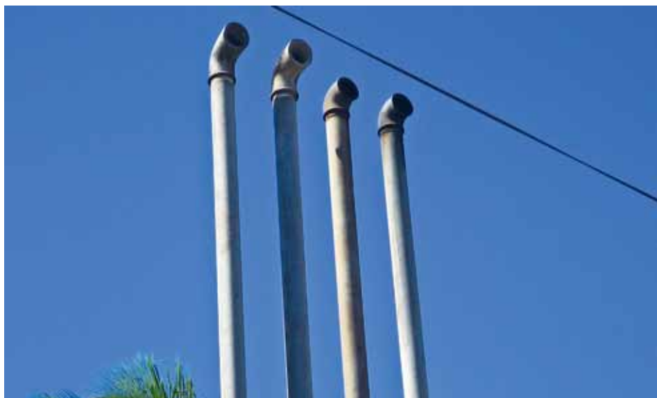
Figura 6.11: Respiros sem válvula de recuperação de vapores. Fonte: Ministério Público.
