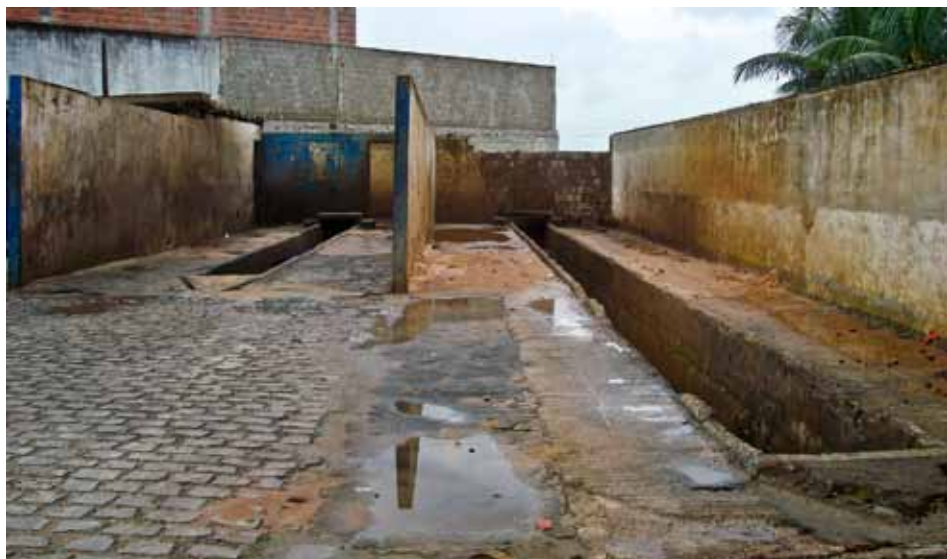
Figura 6.39: Exemplo de duas valas de troca de óleo inadequadas. Fonte: Ministério Público/RN
