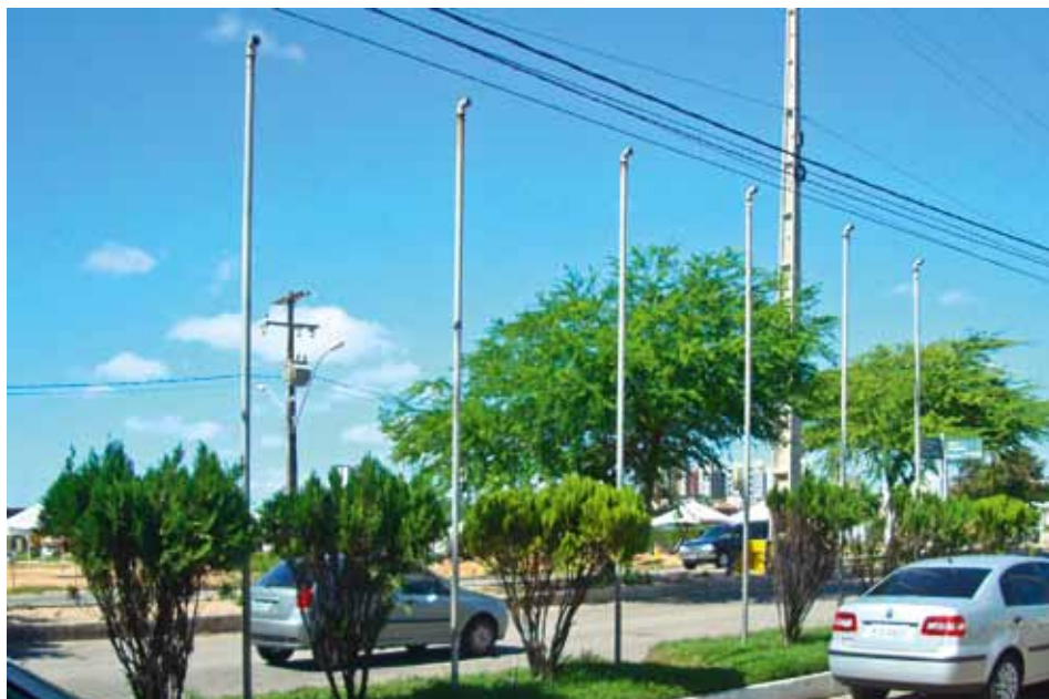
Figura 6.10: Respiros sem mureta de proteção contra abalroamentos. Fonte: Ministério Público/RN
