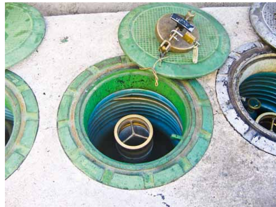
Figura 7.19: Spill container (azul) e bocal selado tipo Y para evitar transbordamentos. Fonte: Ministério Público/RN
