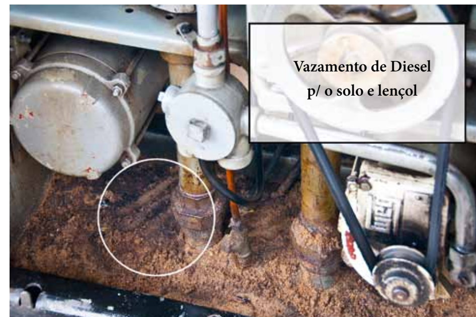
Figura 6.23: Bomba desconforme montada direto no solo sem contenção ( sump ). Fonte: Ministério Público/RN
