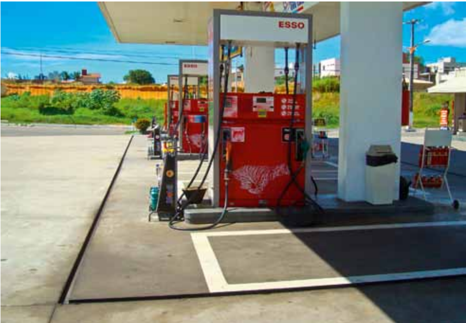
Figura 7.11: Piso do abastecimento em concreto impermeável circundado por canaletas. Fonte: Ministério Público/RN
