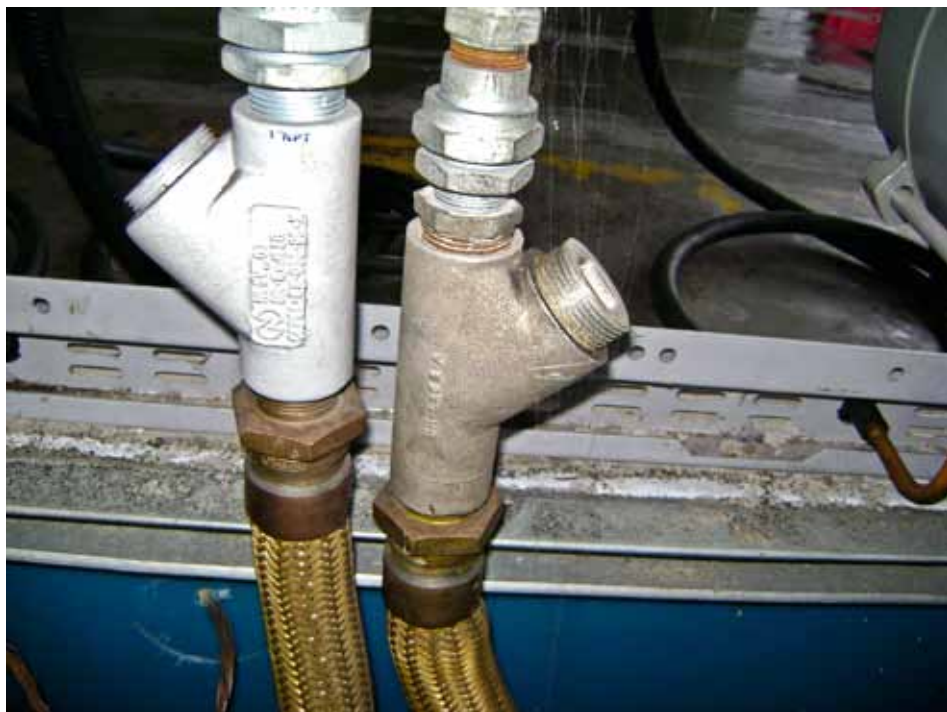
Figura 7.27: Unidades de selagem instaladas dentro do sump de bomba de combustível. Fonte: Ministério Público/RN
