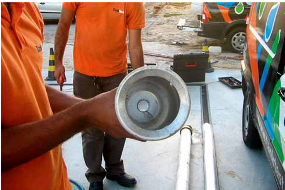
Figura 6.8: Tubos de enchimento de tanques sem válvulas antitransbordamento. Fonte: Ministério Público/RN
