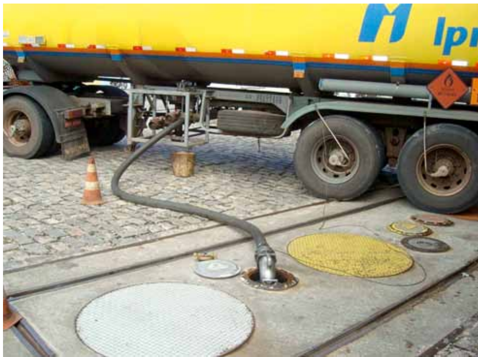
Figura 7.20: Mangueira com joelho de engate rápido para descarga selada. Fonte: Ministério Público/RN
