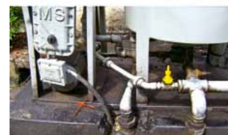
Figura 9.10: Contaminação do solo nos filtros de diesel.
