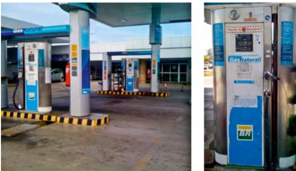
Figura 8.2: a) Ilha de abastecimento, b) Ponto de GNV”dispenser”
