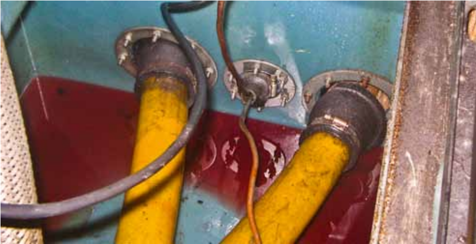
Figura 6.26: Boots danificados e vazamento de Diesel retido no sump da bomba. Fonte: Ministério Público/RN
