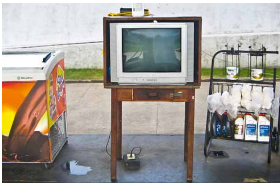
Figura 6.31: Televisor ligado em tomadas elétricas comuns no piso e próximas às bombas. Fonte: Ministério Público/RN
