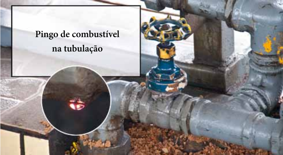
Figura 6.25: Tubulação metálica vazando diretamente da conexão para o solo. Fonte: Ministério Público/RN
