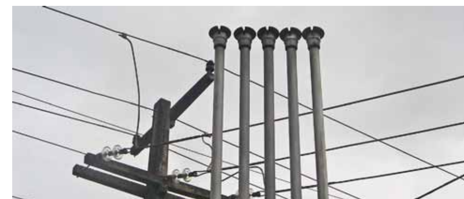
Figura 6.13: Respiros muito próximos de rede elétrica de alta tensão. Fonte: Ministério Público/RN
