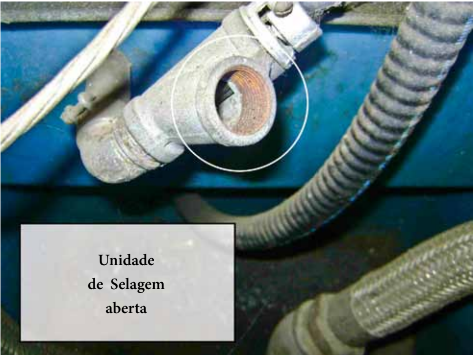
Figura 6.28: Unidade de selagem sem bujão e fixada com conduítes comuns no sump . Fonte: Ministério Público/RN
