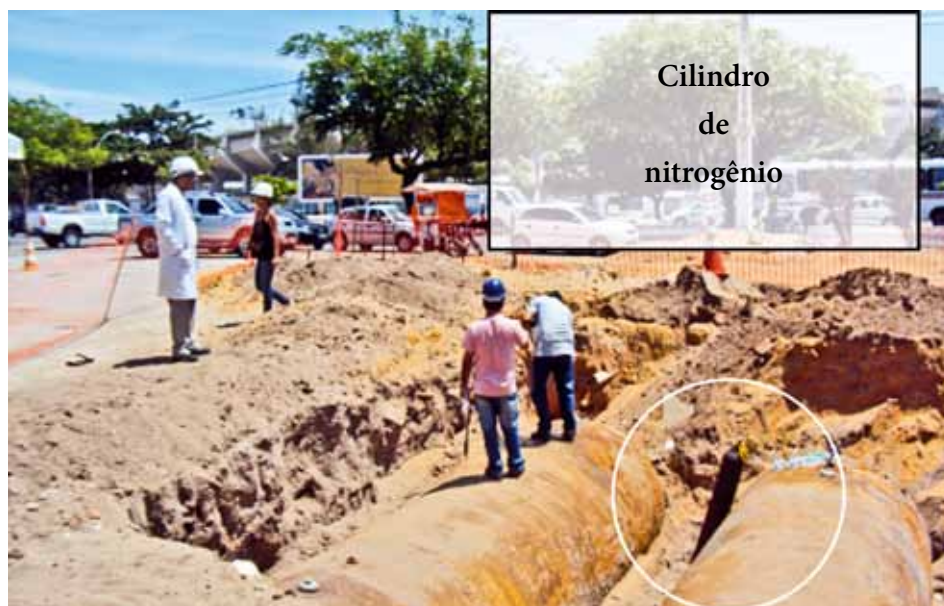
Figura 9.23: Tanques sendo inertizados com N 2 para posterior remoção.
