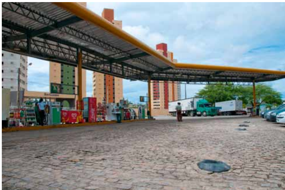
Figura 6.17: Posto de abastecimento com piso em paralelepípedo e sem canaletas. Fonte: Ministério Público/RN
