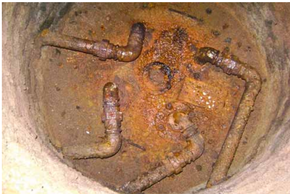
Figura 6.14: Tubulações metálicas com elevado grau de corrosão na câmara de calçada. Fonte: Ministério Público/RN
