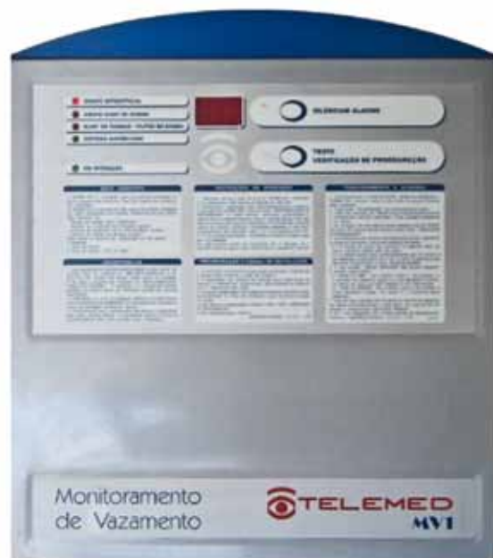
Figura 7.8: Equipamento para o monitoramento eletrônico de vazamentos. Fonte: Ministério Público/RN
