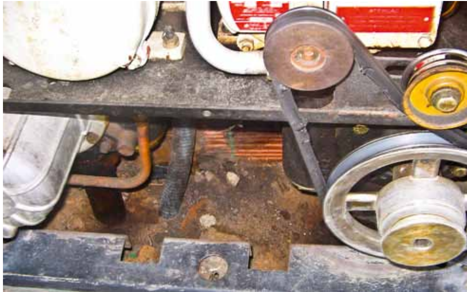
Figura 6.48: Correia da bomba prestes a romper por falta de manutenção. Fonte: Ministério Público/RN
