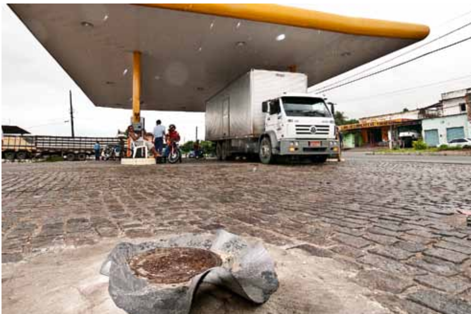
Figura 6.5: Piso da área de tancagem não conforme em paralelepípedo. Fonte: Ministério Público/RN
