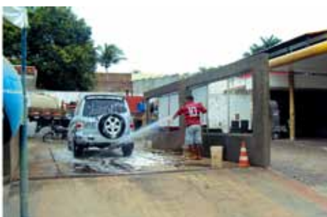
Figura 9.9: Os lava a jato devem possuir canaletas que direcionem o efluente da lavagem para caixa separadora de água/óleo, a fim de que este não percole e infiltre o solo causando a sua contaminação.
