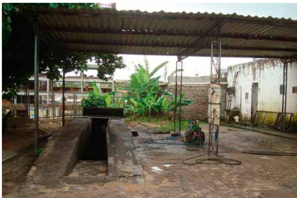
Figura 6.40: Exemplo de rampa mista de troca de óleo e lavagem inadequada. Fonte: Ministério Público/RN
