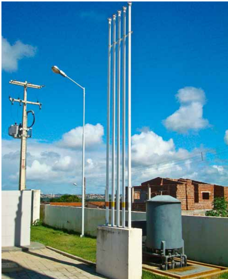
Figura 7.30: Mureta de proteção contra abalroamentos nos respiros. Fonte: Ministério Público/RN
