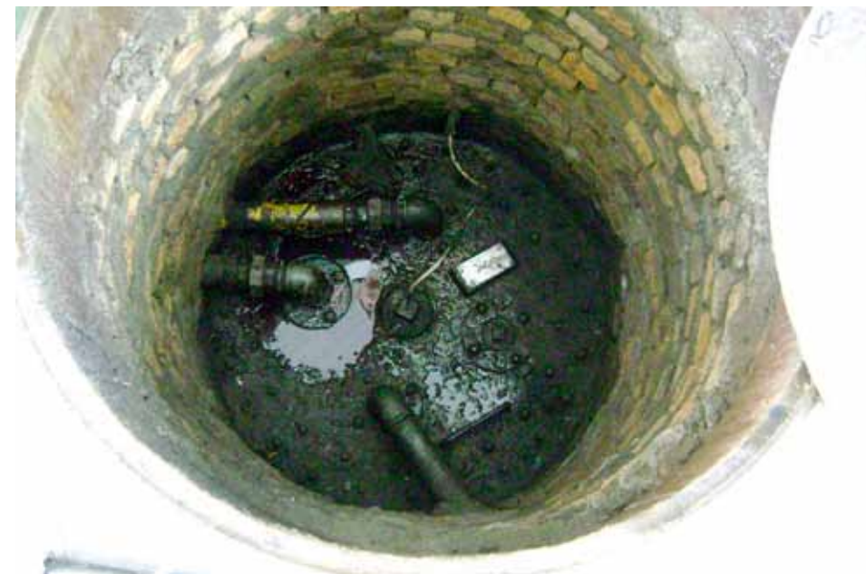
Figura 6.15: Tubulações metálicas vazando em câmara de calçada sem contenção. Fonte: Ministério Público/RN
