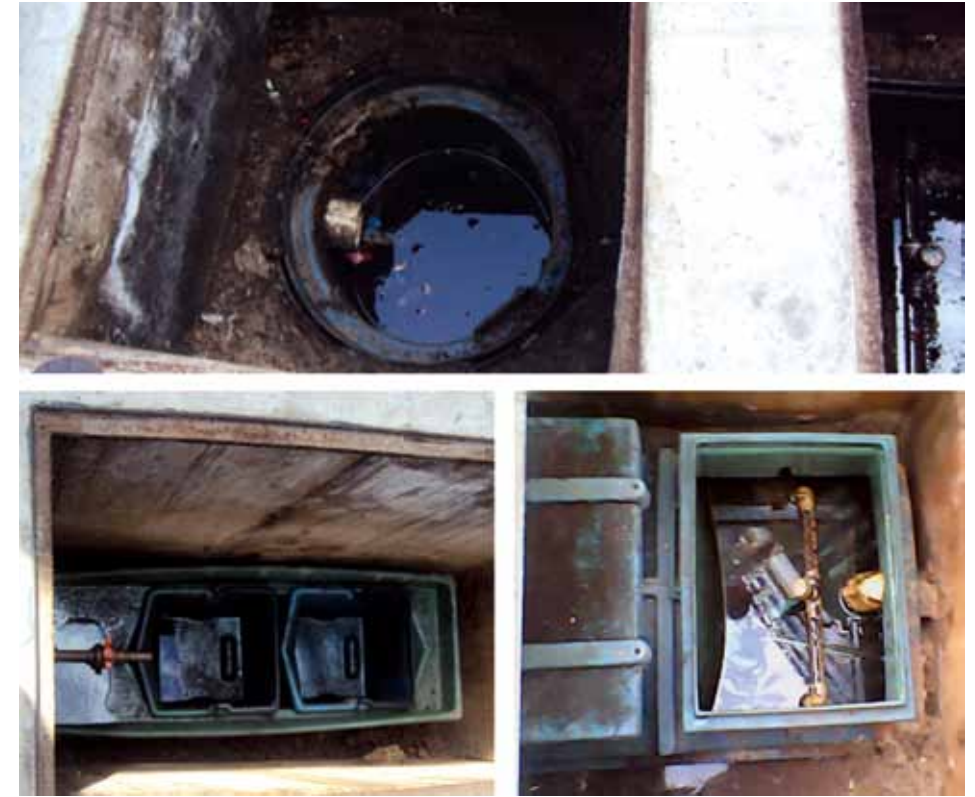
Figura 9.29: Efluente na caixa SAO (caixa separadora de água/óleo).
