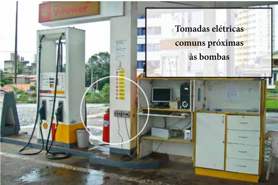
Figura 6.29: Tomadas elétricas comuns a menos de 5 metros de uma bomba. Fonte: Ministério Público/RN
