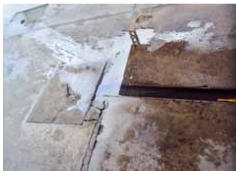
Figura 9.7: A água transbordando nas canaletas, devido a caixa sepadora de água/óleo ter atingido o seu limite.
