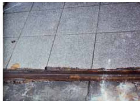
Figura 9.8: Canaletas não conservadas causam a infiltração do óleo no solo.
