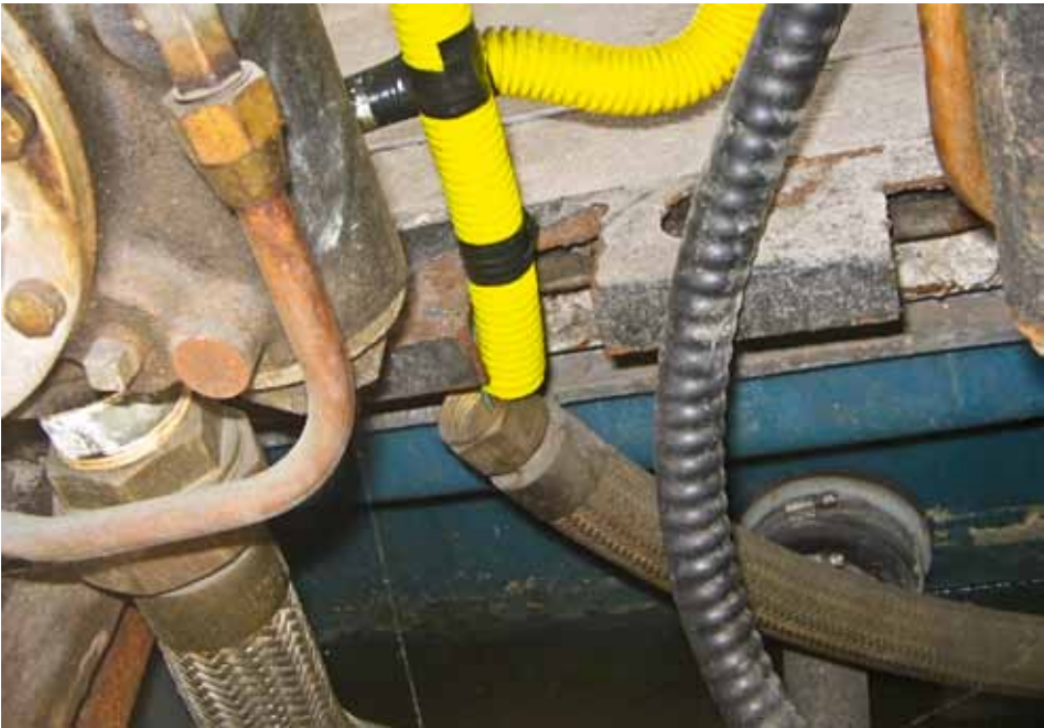
Figura 6.27: Conduítes comuns em vez de tubos à prova de explosão no sump da bomba. Fonte: Ministério Público/RN
