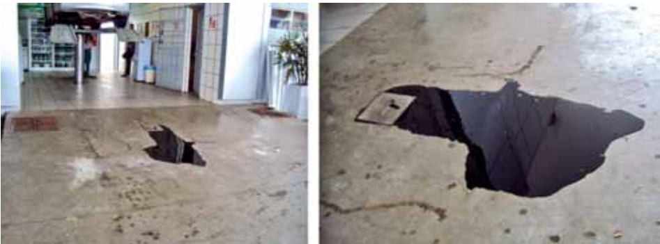
Figura 9.4: Vazamento no sistema de armazenamento subterrâneo da troca de óleo.
