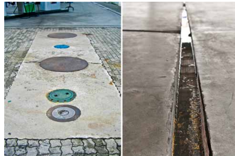
Figura 6.7: Piso da área de tancagem não conforme sem canaletas. Fonte: Ministério Público/RN
