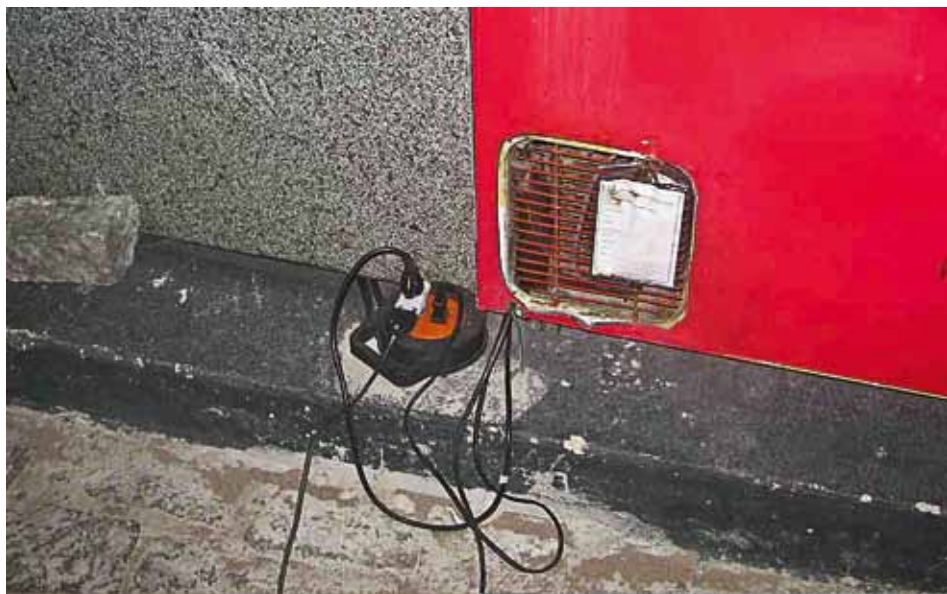
Figura 6.30: Freezer ligado em tomadas elétricas comuns e próximas às bombas. Fonte: Ministério Público/RN
