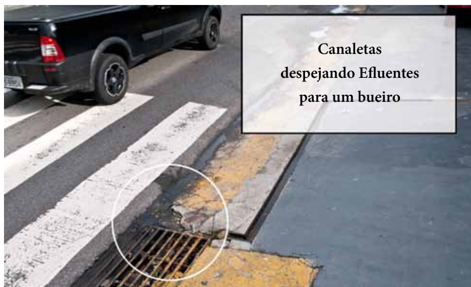
Figura 6.20: Outro exemplo de canaletas despejando efluentes para bueiro. Fonte: Ministério Público/RN
