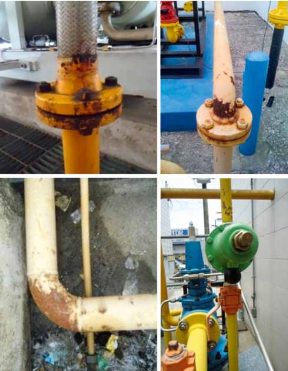
Figura 8.3: a), b), c) Detalhes de corrosão em flanges e tubulação; d) Válvula PSV com obturador antes da válvula, não apresentando a tarja de identificação e a placa com a data de calibração e a próxima verificação.
