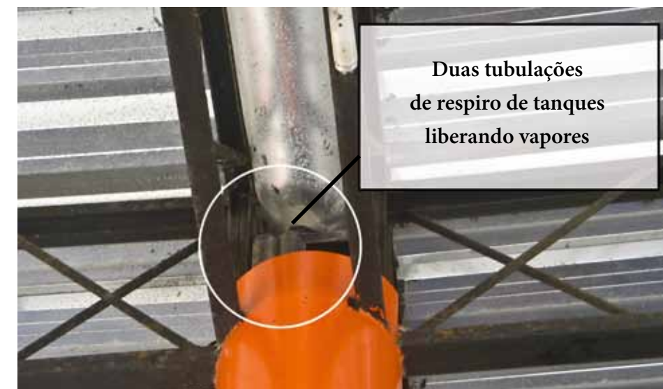
Figura 6.12: Respiros liberando vapores embaixo da cobertura. Fonte: Ministério Público/RN
