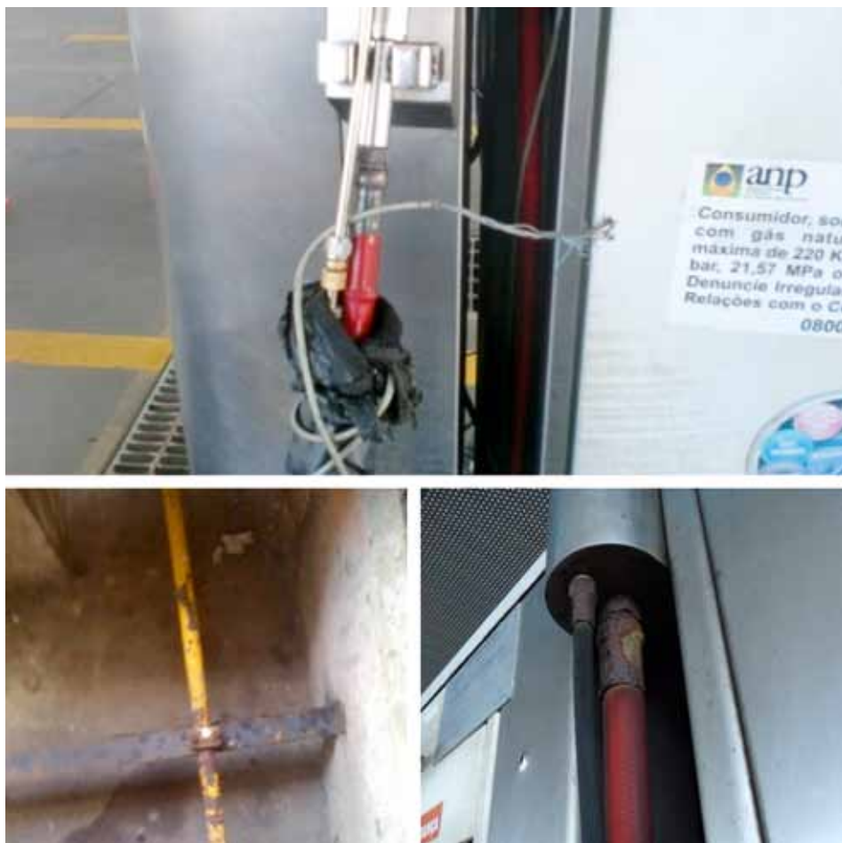
Figura 8.5: a) Aterramento inadequado; b) Corrosão em tubulação de alta pressão; c) Corrosão avançada nas conexões e terminais das mangueiras.
