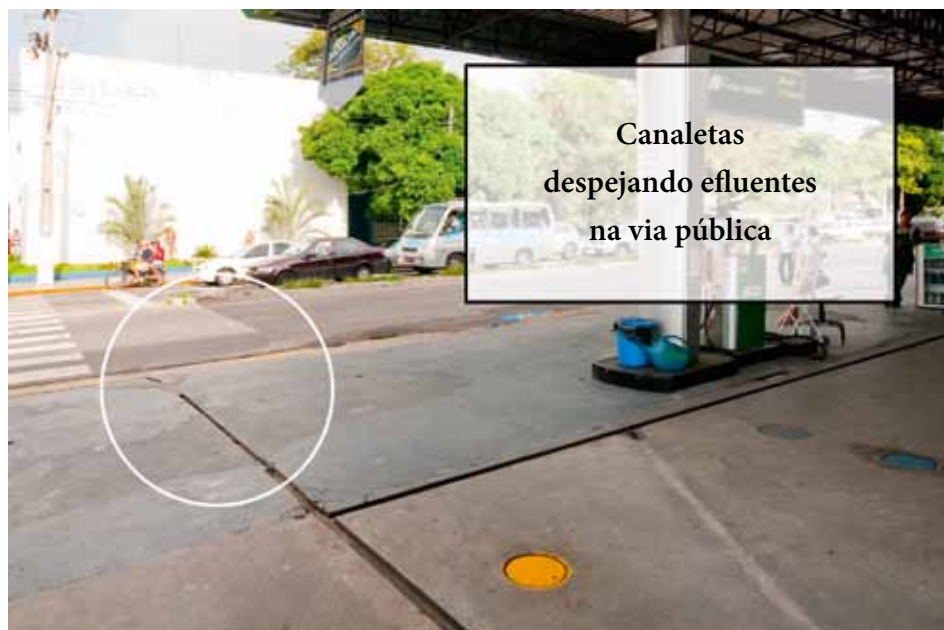
Figura 6.19: Não conformidades das canaletas despejando efluentes na via pública. Fonte: Ministério Público/RN
