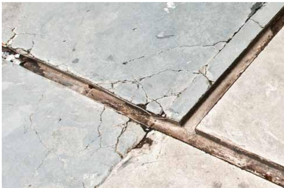
Figura 6.22: Piso apresentando várias trincas e com canaletas danificadas. Fonte: Ministério Público/RN
