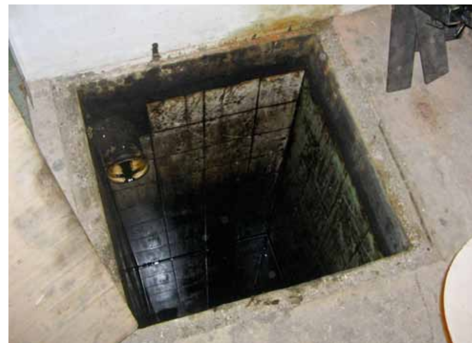
Figura 6.41: Tanque em alvenaria e azulejo comum para armazenar OL. Fonte: Ministério Público/RN
