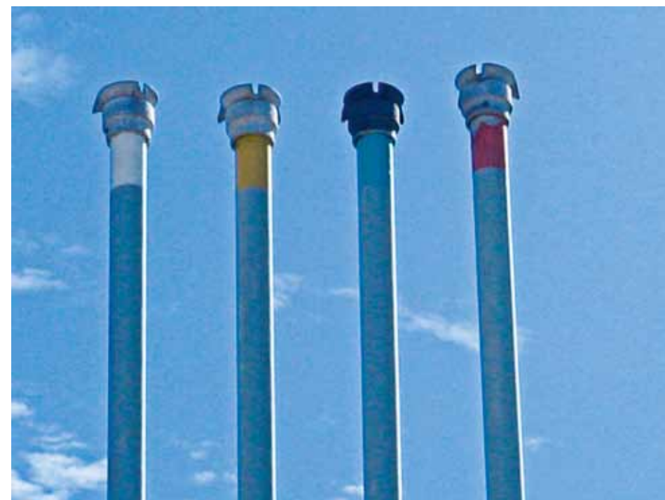
Figura 7.23: Válvulas de recuperação de vapores nos terminais de respiro dos tanques. Fonte: Ministério Público/RN
