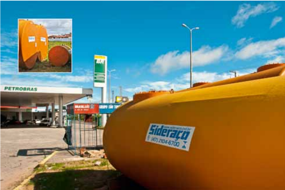
Figura 7.6: Tanques jaquetados de parede dupla aguardando o momento da instalação. Fonte: Ministério Público/RN
