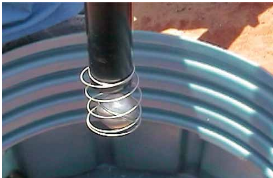
Figura 7.22: Float Ball montada na saída para o respiro dos tanques. Fonte: Ministério Público/RN
