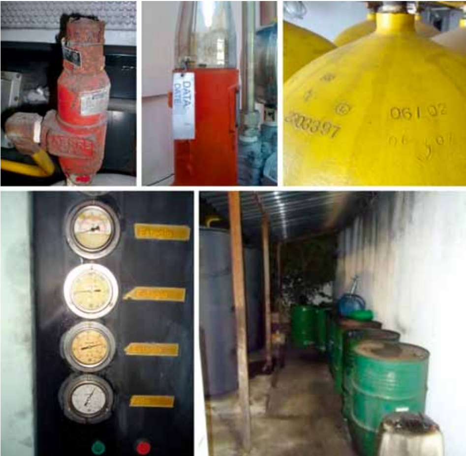
Figura 8.4: a) Válvula PSV danificada; b) Válvula PSV faltando plaqueta e certificado de calibração; c) Cilindro de armazenagem vencido; d) Instrumentos sem conservação; e) Armazenagem de óleo lubrificante inadequada.
