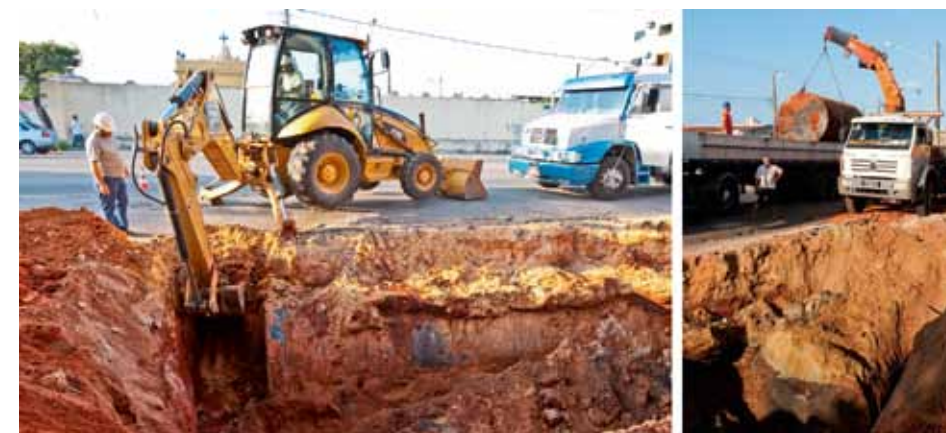
Figura 9.24: Remoção de Tanque.
