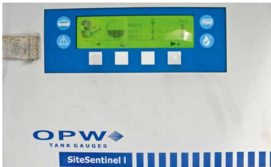
Figura 7.9: Equipamento específico para o controle de estoque eletrônico. Fonte: Ministério Público/RN
