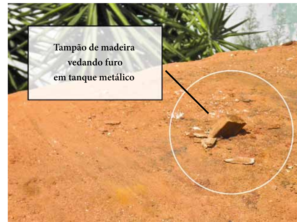
Figura 6.4: Furo no costado superior de um tanque simples (metálico). Fonte: Ministério Público/RN
