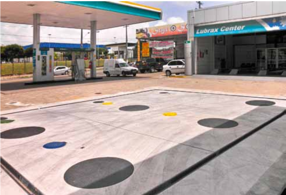
Figura 7.12: Piso da área dos tanques em concreto impermeável circundado por canaletas. Fonte: Ministério Público/RN
