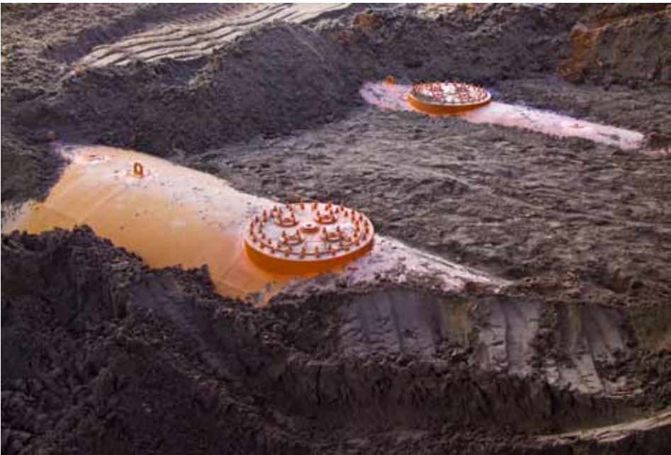
Figura 7.7: Tanques ecológicos soterrados em fase de instalação. Fonte: Ministério Público/RN
