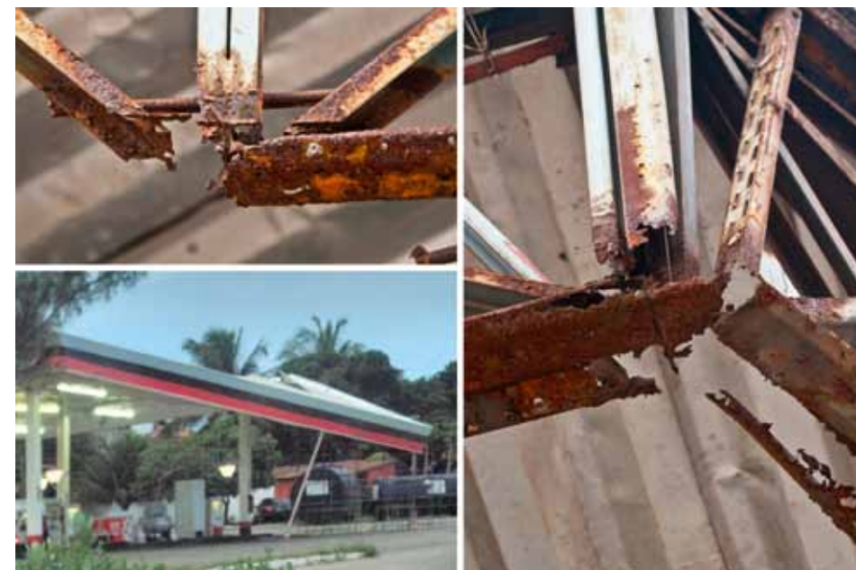
Figura 6.44: Desabamento da cobertura, consequência da corrosão na estrutura. Fonte: Ministério Público/RN
