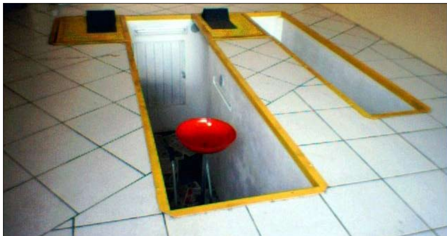
Poço de lubrificação impermeabilizado
