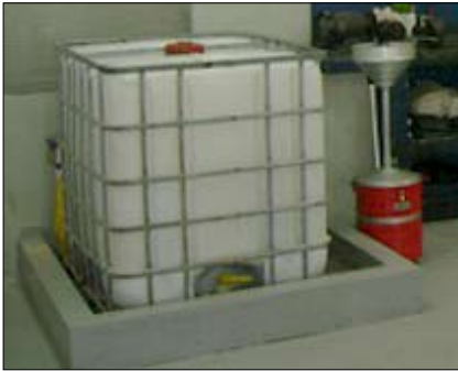
"Container" em bacia de contenção
